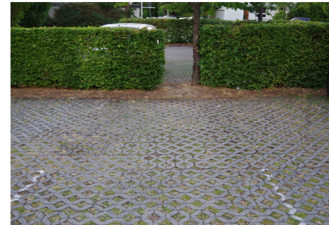
Abbildung 21: Stellplätze versiegeln wertvolle Flächen und tragen zur Aufheizung von Siedlungsgebieten bei; durch Vorgaben zur Verwendung wasserdurchlässiger Oberflächenbefestigungen und zur Begrünung von Stellplatzanlagen können diese Effekte abgemildert werden (eigene Aufnahme)
