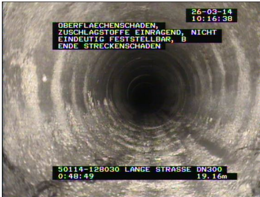
Erneuerung der Haltung
