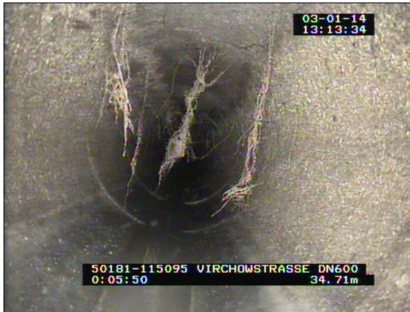
Renovierung der Haltung
