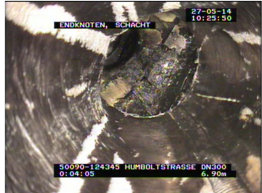
Erneuerung der Haltung
