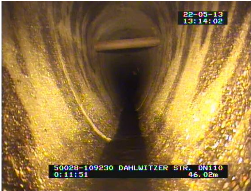
Erneuerung der Haltung
