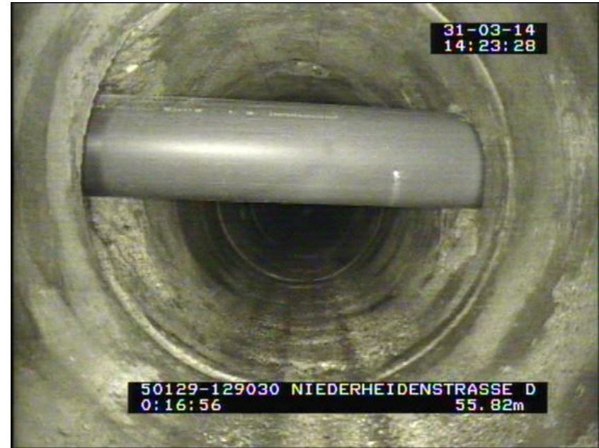
Renovierung der Haltung
