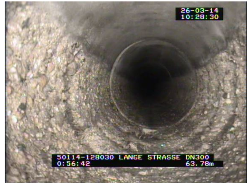
Erneuerung der Haltung
