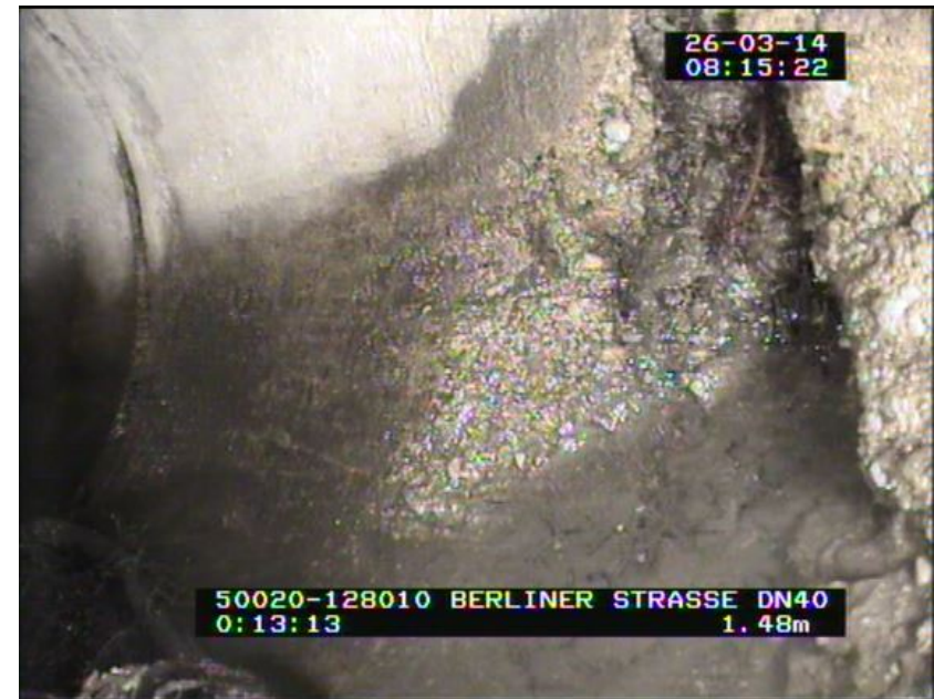
Renovierung der Haltung
