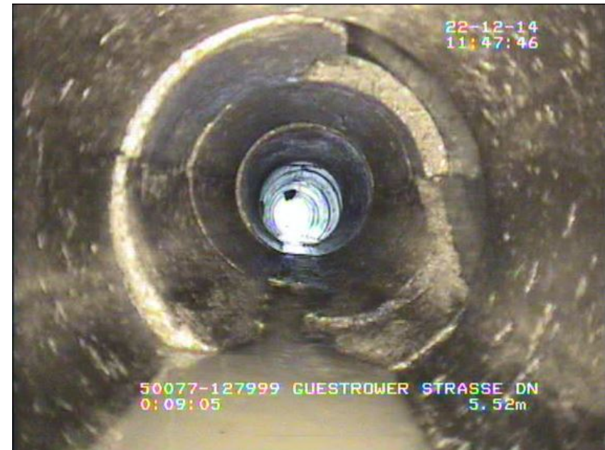
Erneuerung der Haltung
