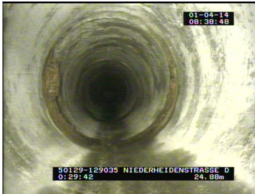
Renovierung der Haltung
