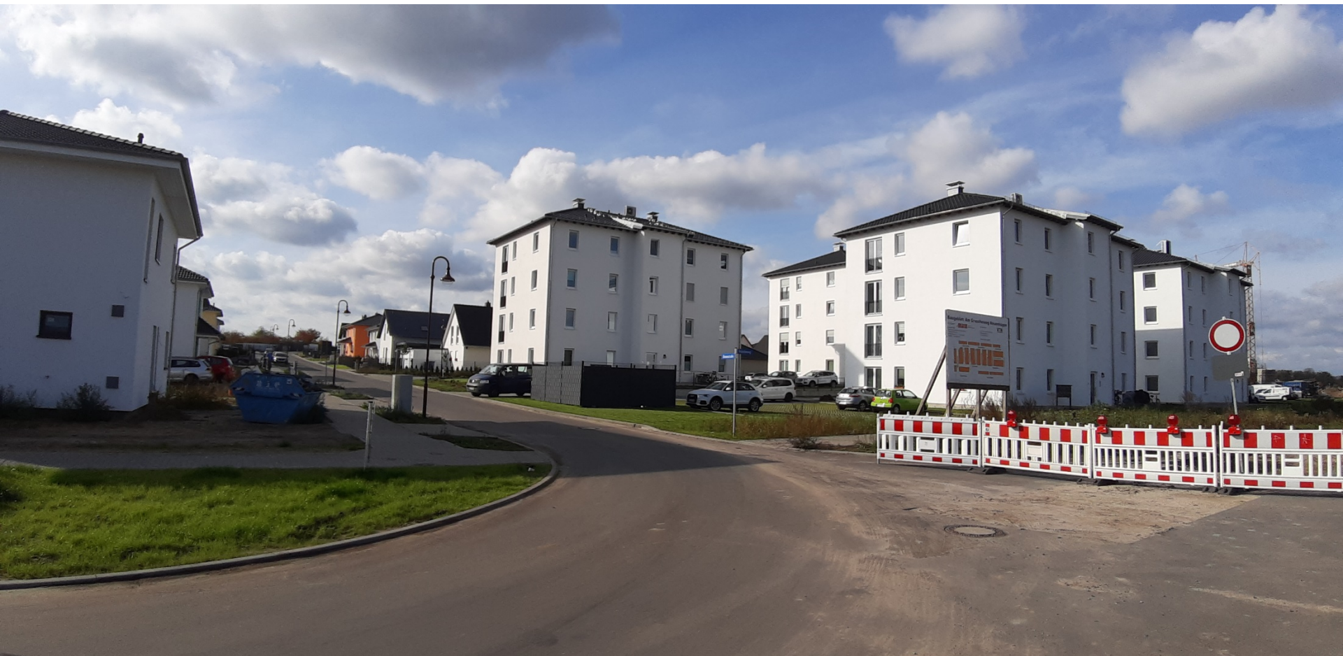
Das Baugebiet am Gruscheweg
